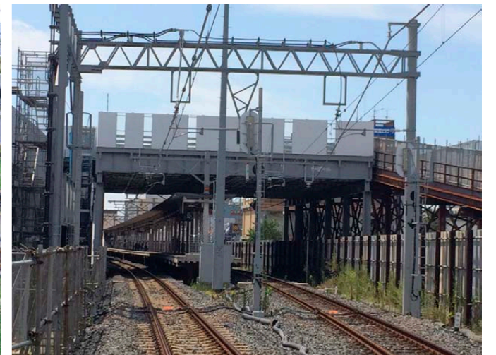
鉄道上空工事用作業ヤード(大阪府)
