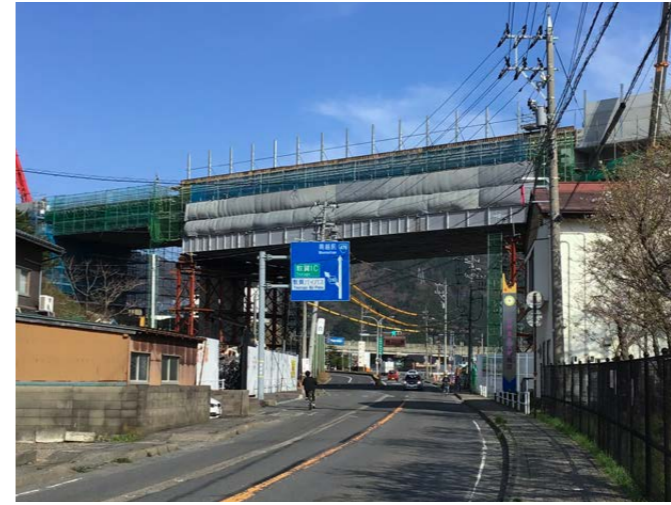
上部工架設工事用仮橋(福井県)
