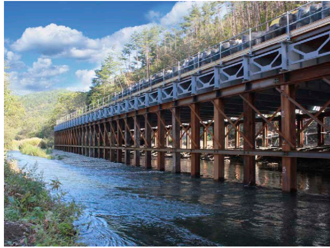
河川縦断工事用作業ヤード(岩手県)
