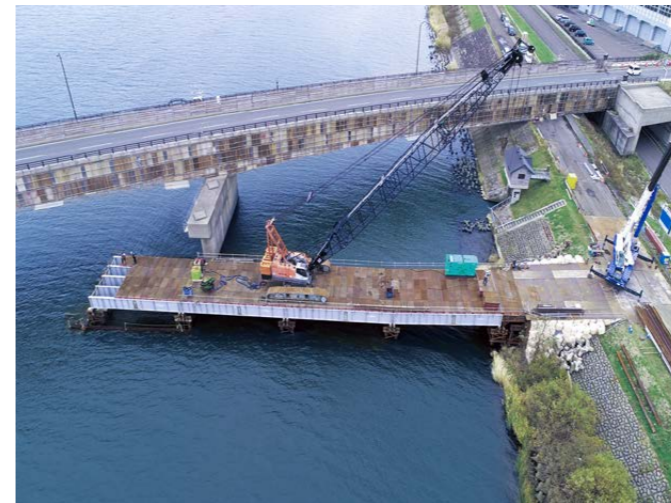
橋脚耐震補強工事用仮橋(秋田県)
