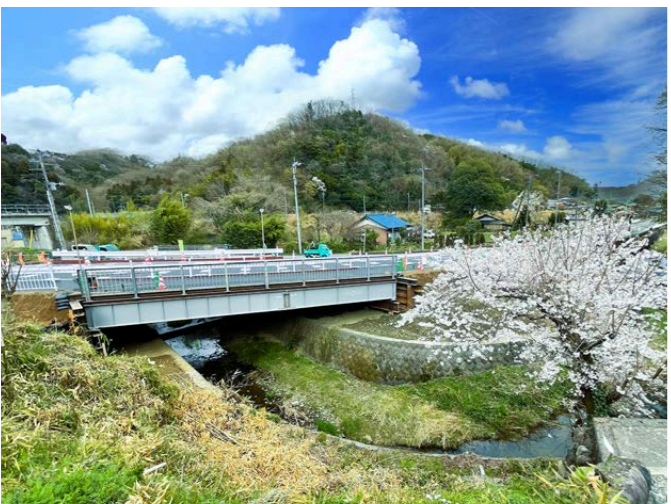
架替用迂回路仮橋(埼玉県)
