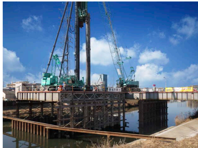
大型重機作業用仮橋(埼玉県)
