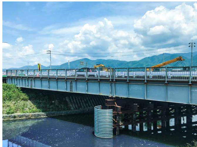
架替用迂回路仮橋(京都府)
