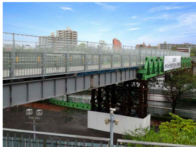
歩道用仮橋(東京都)
