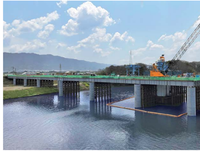
架替工事用仮橋(福岡県)
