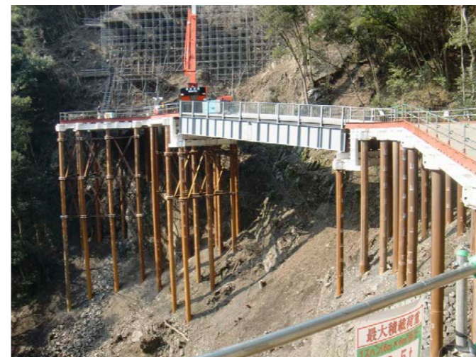
地すべり地帯回避仮橋(徳島県)
