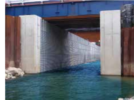
仮排水路での使用例-1
