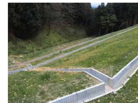
排水路での使用例
