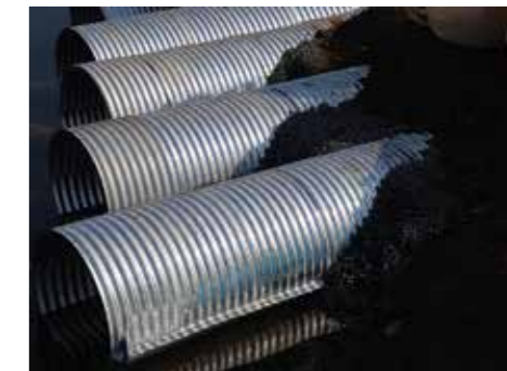
仮設工用道路の排水路での設置状況
