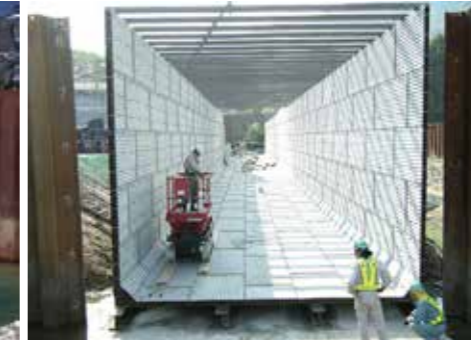
仮排水路での使用例-2
