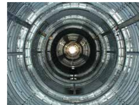
引き出しトンネル内部(設備設置前)
