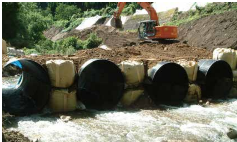
円形パイプ施工状況
