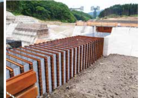
仮排水路での使用例-3
