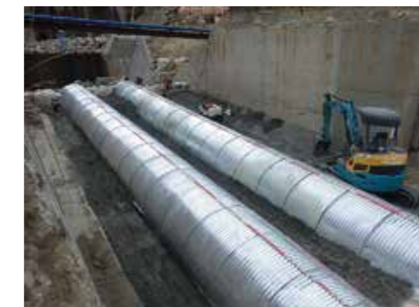
災害復旧時の応急排水路での設置状況
