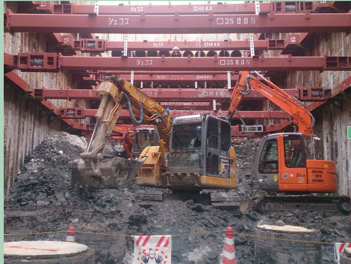
道路涵渠工事
