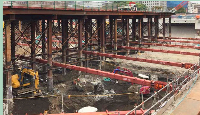
商業施設新築工事
