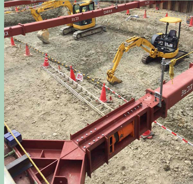
マンション新築工事
