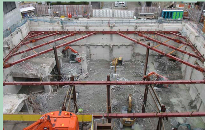
商業施設解体新築工事
