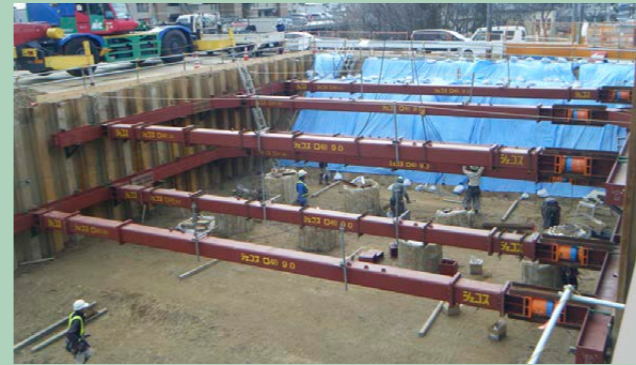
橋脚新設工事
