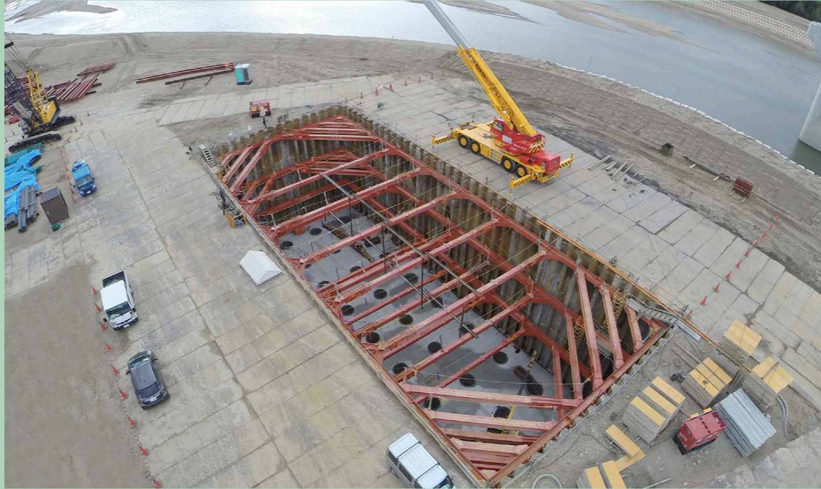
橋脚基礎工事
