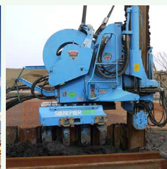
サイレントパイラー工法
