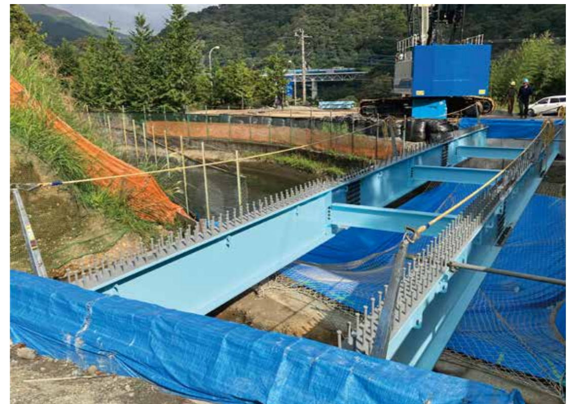
桁架設完了
