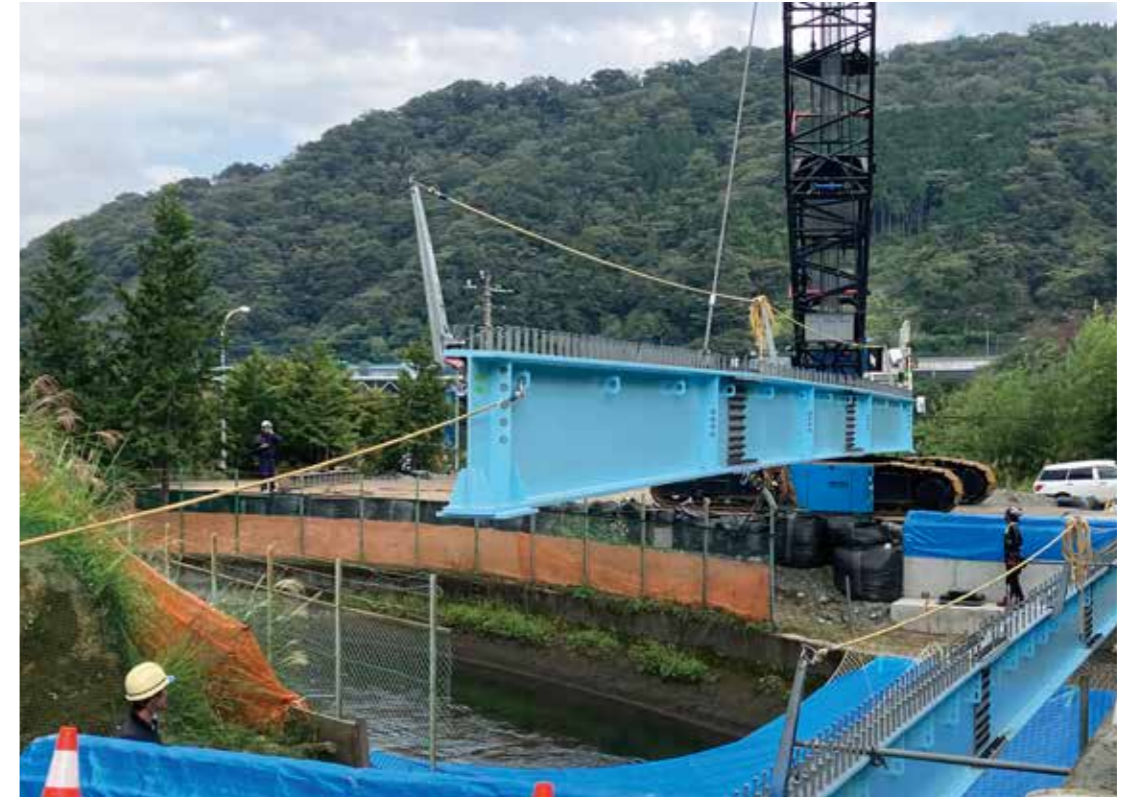
桁架設工
