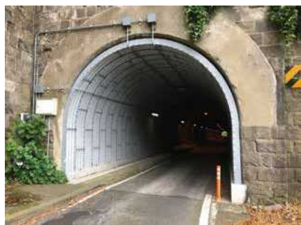
施工事例写真
