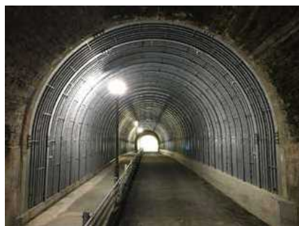
施工事例写真
